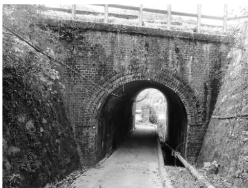
■大師第16号拱渠の東側ポータル
