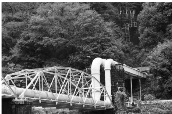
■武庫川第1水管橋(旧福知山線(当時)上越部)
