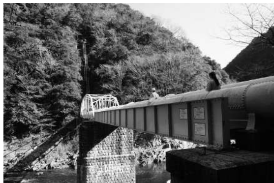
■武庫川第2水管橋(トラスとプレートガーター)
