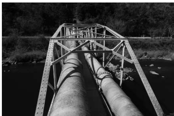
■武庫川第1水管橋(上部の管路)
