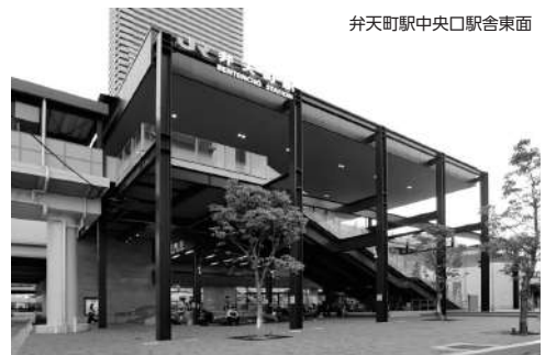
弁天町駅中央口駅舎東面
