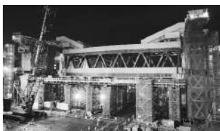
トラス橋横取り作業中写真
