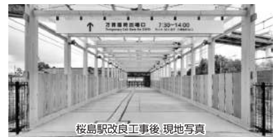
桜島駅改良工事後 現地写真
