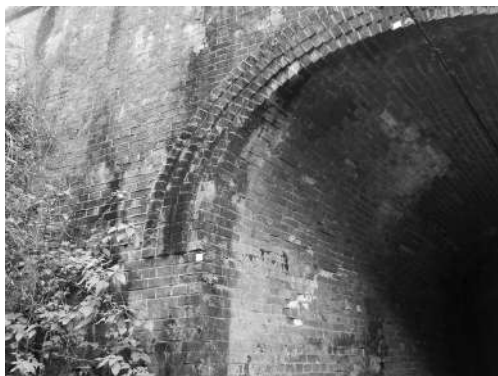
■水平に積まれているアーチ部の煉瓦
