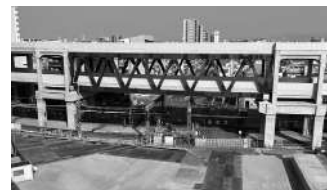
トラス橋施工完了写真
