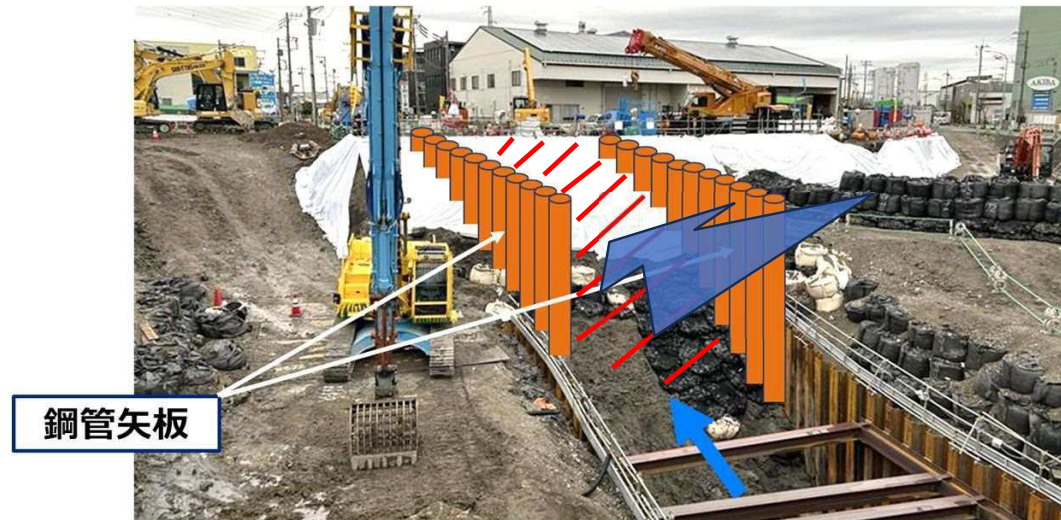
③上流からキャビンに向けて掘削(イメージ)
