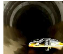
ドローンによる目視調査
