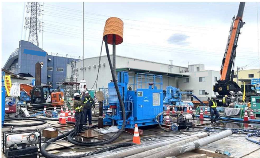
②地上からキャビンに向けて縦に掘削(地盤改良施工状況)
