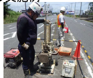
(貫入試験による調査)
