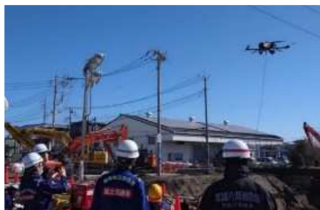
ドローン調査
