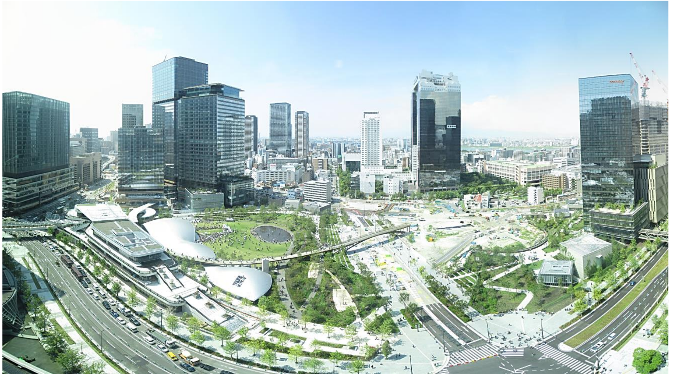
うめきた2期区域の全景（2024.9.6撮影）UR都市機構
