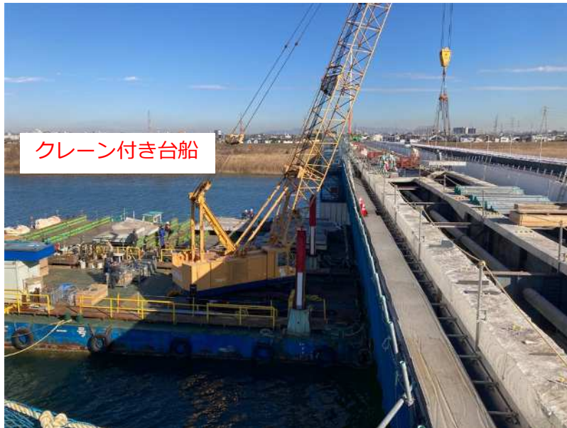
床版撤去状況
