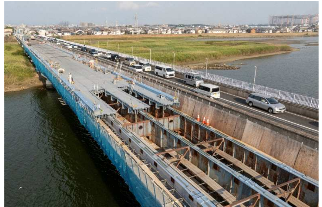
新設鋼床版架設状況
