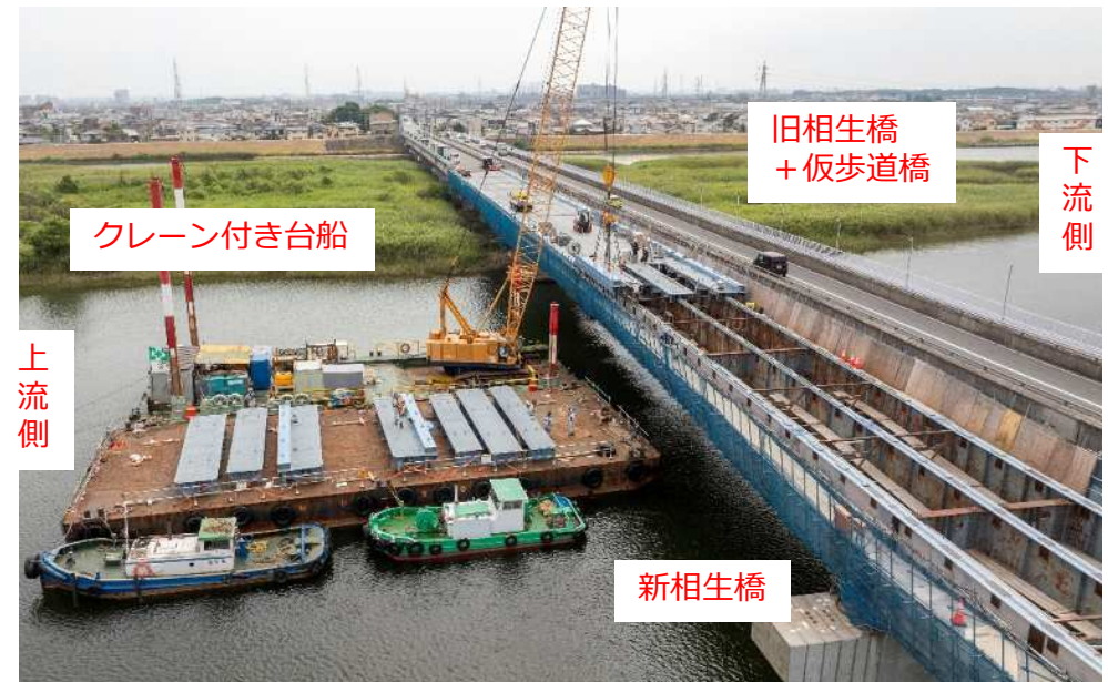
鋼床版架設状況
