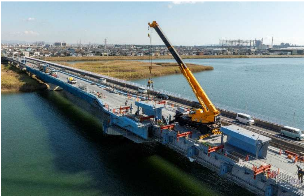
拡幅桁架設状況
