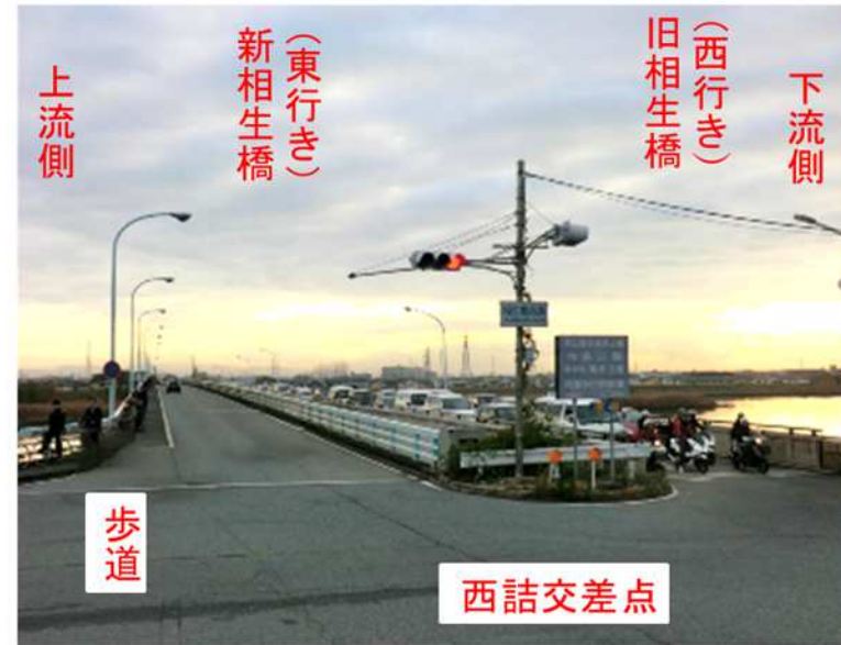
工事前渋滞状況
