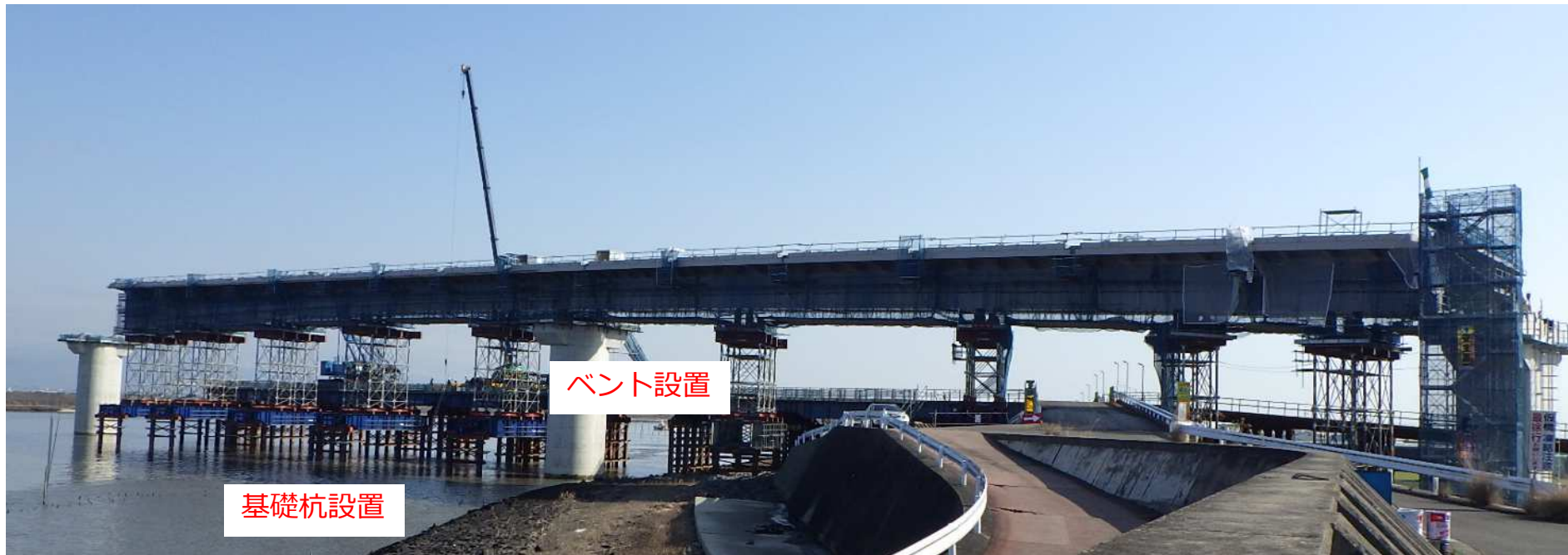
例 ベントを使用した架設(多点支持状態)
