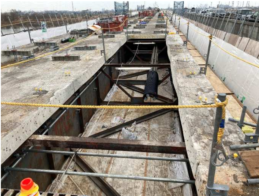
既設床版撤去状況
