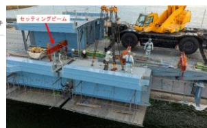
セッティングビームによる拡幅桁架設
