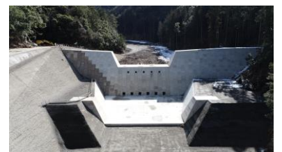
2号砂防堰堤完成写真
