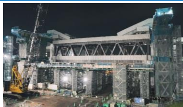
トラス橋横取作業中写真
