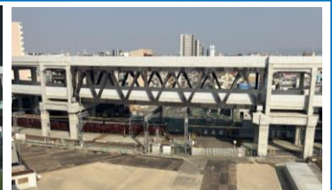
トラス橋施工完了写真
