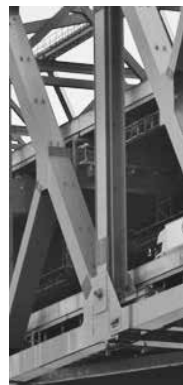
■港大橋における「対震」補強の例④ 落橋防止吊りケーブル
