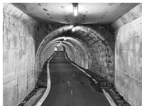
■トンネル内部にある石造りの東側坑門
