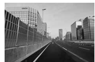
▲工事後(縦目地がなくなった路面)
