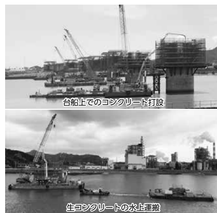
生コンクリートの水上運搬
