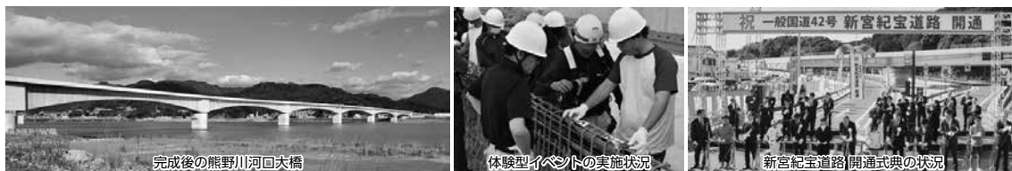
完成後の熊野川河口大橋
