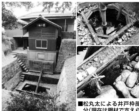
■龍ヶ池揚水機場全景
