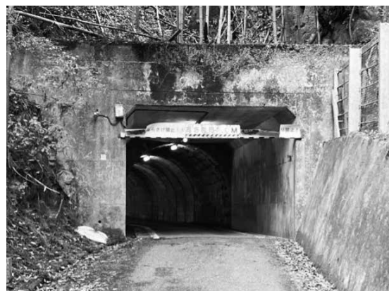
■東側(木津側)坑門
