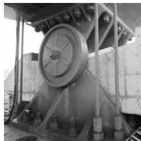
■港大橋における「対震」補強の例③ 支承脱落防止
