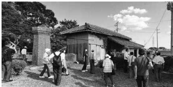
■龍ヶ池揚水機場の現地見学会の様子
