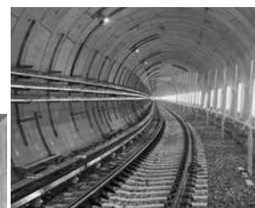
シールドトンネル区間完成写真
