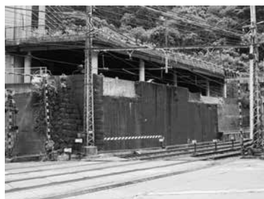
■旧上関寺町架道橋橋台
