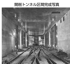
開削トンネル区間完成写真
