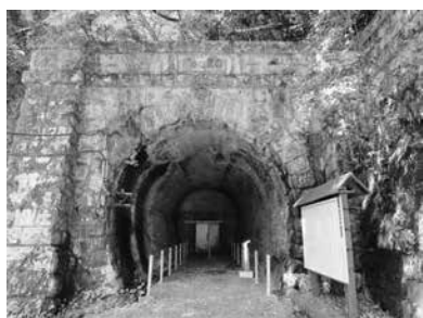
■逢坂山ずい道 東坑口
