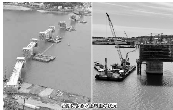
台船による水上施工の状況
