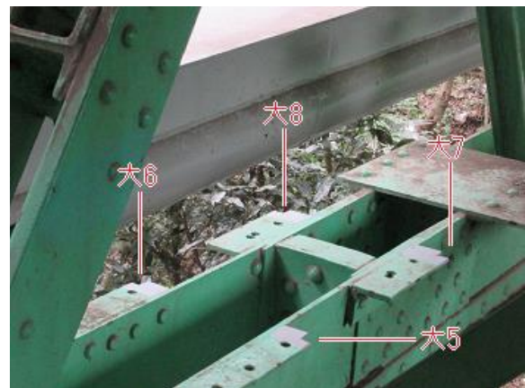
図 4.7 大宮橋からの試験片採取位置(上流側主構から大1～大4、下流側主構から大5～大8を採取)
