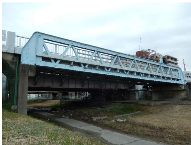
図 1.4 供用時の浜中津橋の側景(下流側より撮影)
