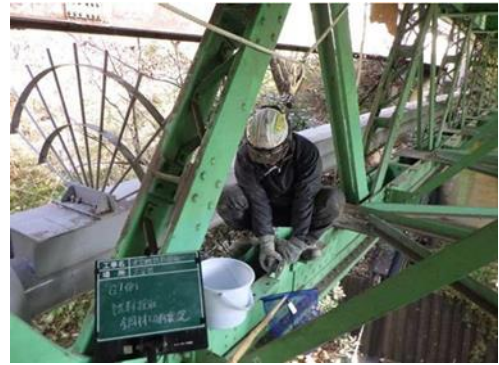
図 4.5 大宮橋からの試験片採取作業状況
