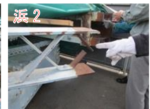
図 4.7 大宮橋からの試験片採取位置(上流側主構から大1～大4、下流側主構から大5～大8を採取)
