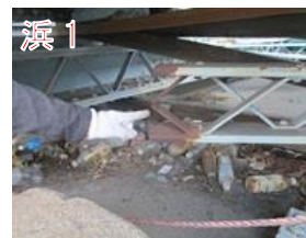
図 4.7 大宮橋からの試験片採取位置(上流側主構から大1～大4、下流側主構から大5～大8を採取)
