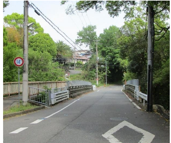
図 1.10 大宮橋の橋面(左岸側より撮影)
