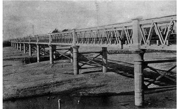
図 1.1 明治 7 年に架けられた鉄道橋のひとつ武庫川橋 (出典：参考文献 1)
