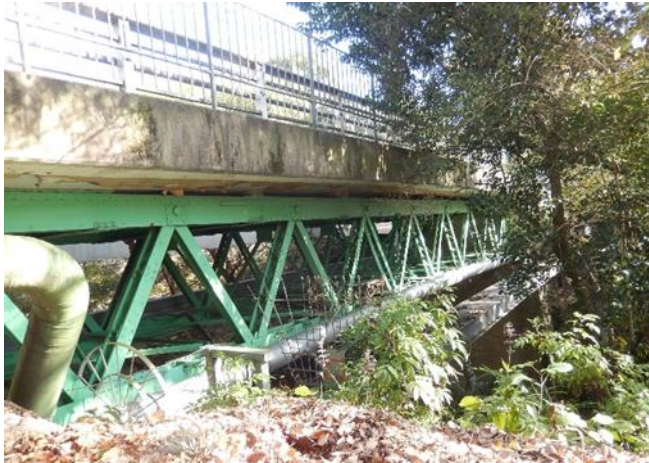
図 1.9 大宮橋の側景(上流側より撮影)
