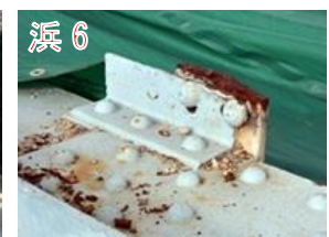
図 4.8 浜中津橋からの試験片採取位置(下流側主構から浜1、浜3、浜5、上流側主構から浜2、浜4、浜6を採取)
