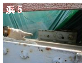
図 4.8 浜中津橋からの試験片採取位置(下流側主構から浜1、浜3、浜5、上流側主構から浜2、浜4、浜6を採取)
