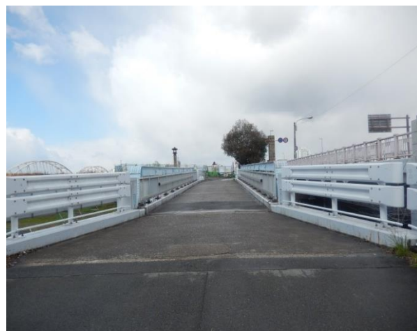
図 1.5 供用時の浜中津橋の橋面(左岸側より撮影)
