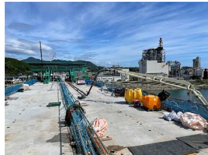
⑥ブームから橋面上の水平配管に圧送
