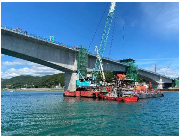
⑦打設状況の全景
