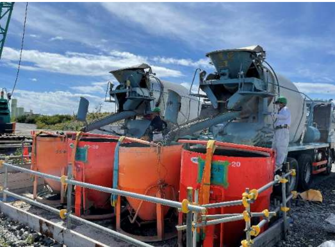
①トラックミキサー車から生コンをバケットへ投入
