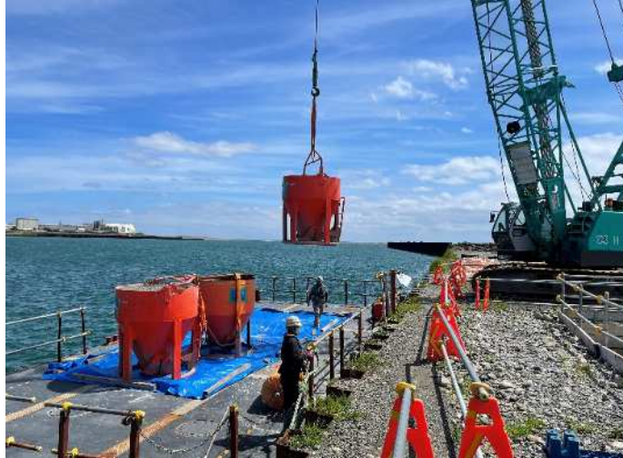
②バケットを資材台船へクレーンで揚重
