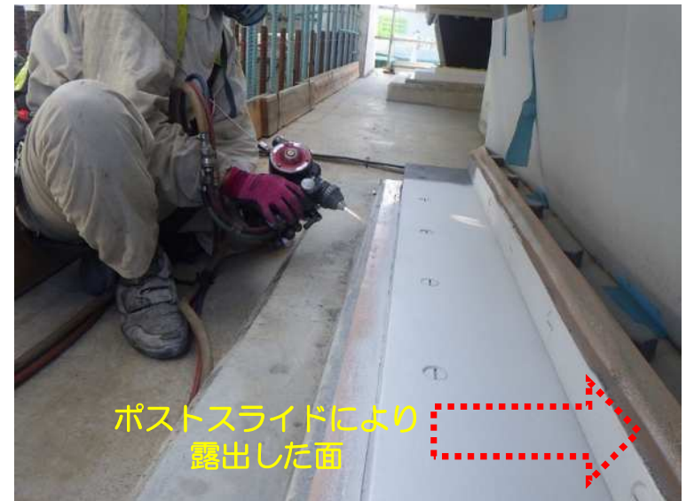
〔現場金属溶射の状況〕
