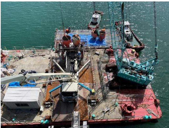
④バケットを資材台船からポンプ車上の架台へ揚重
