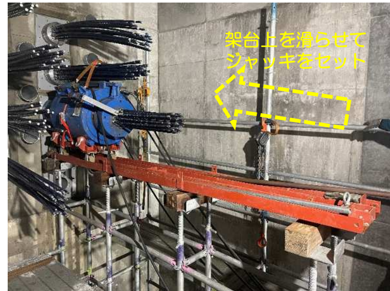
〔緊張ジャッキのセット状況〕
