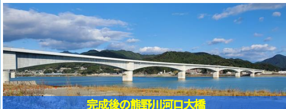
完成後の熊野川河口大橋
