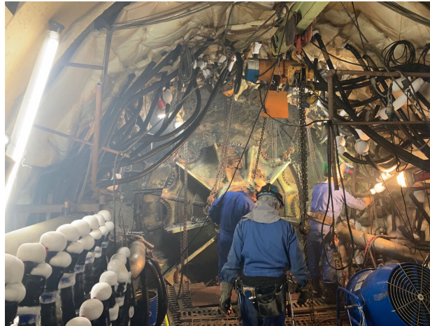
シールド機解体・既設管鏡切
