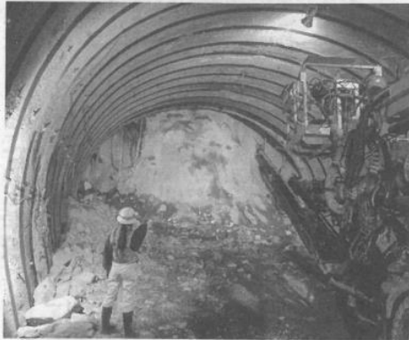
トンネル工事を担当する小西所長
