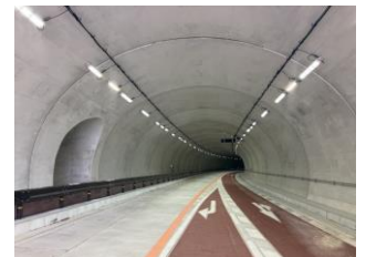
トンネル完成後内状況
