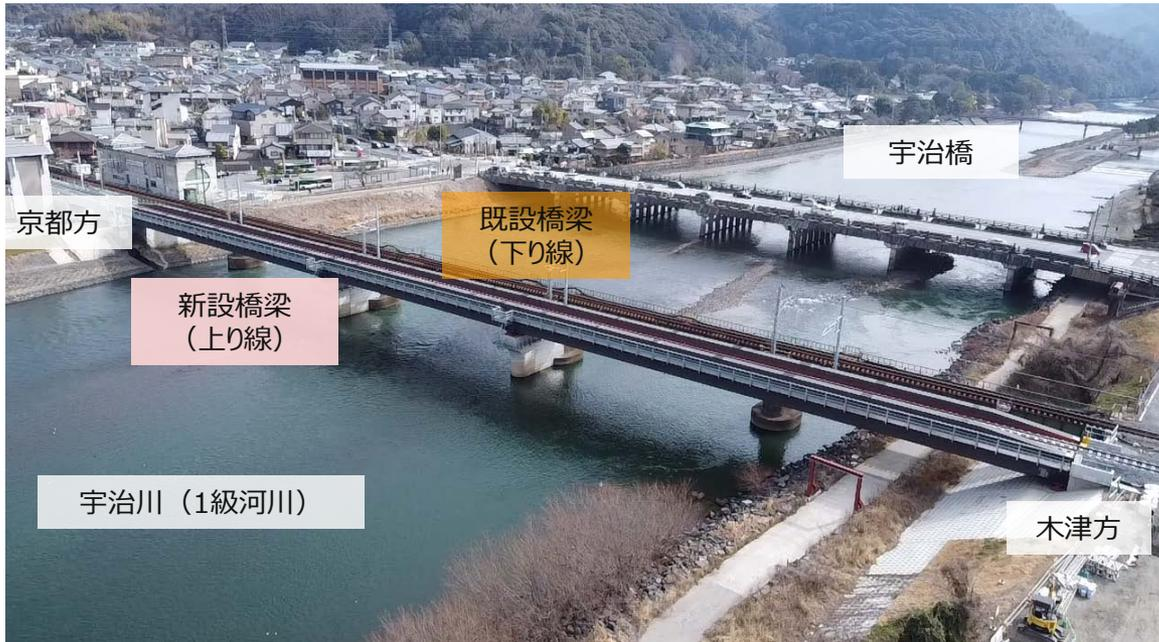
周辺の眺望景観を阻害しないため桁高を極力抑え、さらに桁下端を既設橋梁と揃えたうえで宇治橋の車窓からの眺めにも配慮した構造に選定
