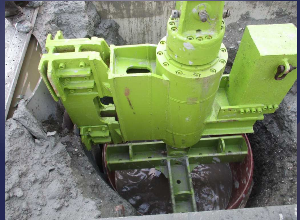
《修正掘削状況》
