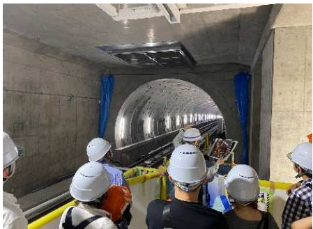
4. 地下駅の箕面船場阪大前駅では、南側でシールドトンネル部を見学していただきました。
