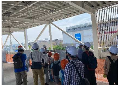
9. 高架駅の箕面萱野駅では、商業施設に直結する北側の改札から入場し、新しい駅を見学していただきました。
