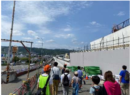
7. 箕面船場阪大前駅から箕面萱野駅までは、延伸線の構造物を見ながら徒歩で移動していただきました。
