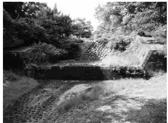
■第5えん堤(床固工)
