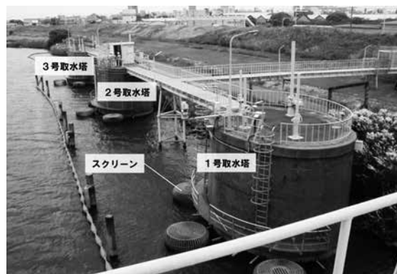
■柴島浄水場1～3号取水塔
