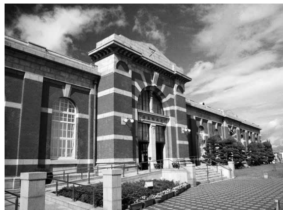
■柴島浄水場旧第1配水ポンプ場(現水道記念館)
