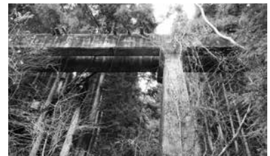
鳴戸谷林道の廃高架橋
