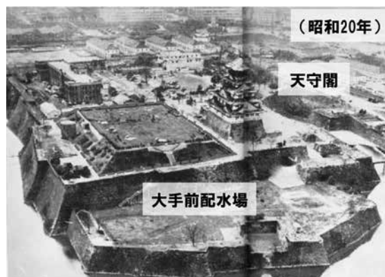
■大手前配水場
