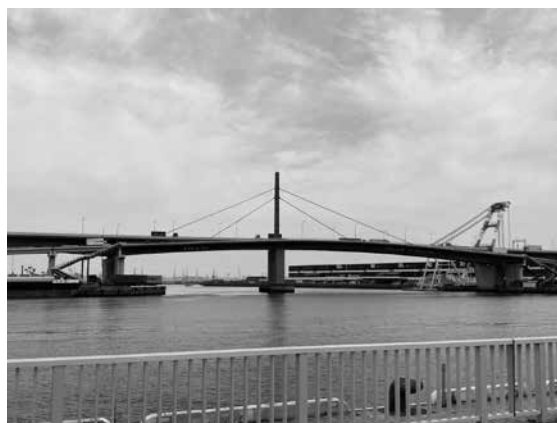
■全景 (なぎさ公園から望む)
