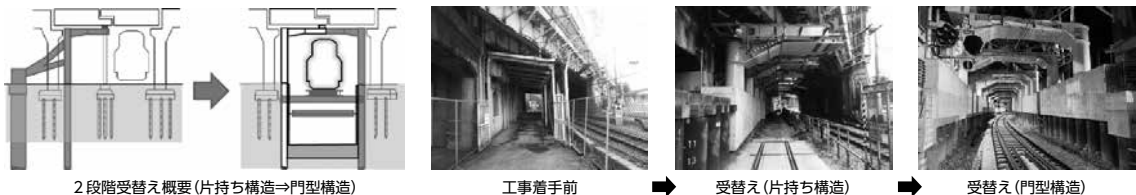
2段階受替え概要(片持ち構造⇒門型構造)
