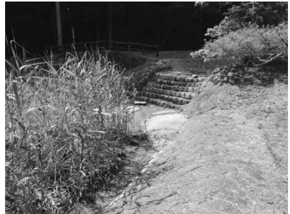
■第1えん堤(床固工)
