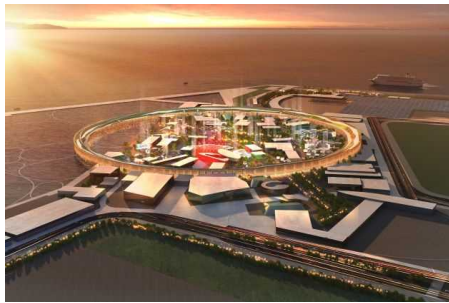
円周約2km、直径（内径）約610m、 高さ12m、幅30m
