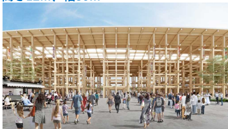
円周約2km、直径（内径）約610m、 高さ12m、幅30m
