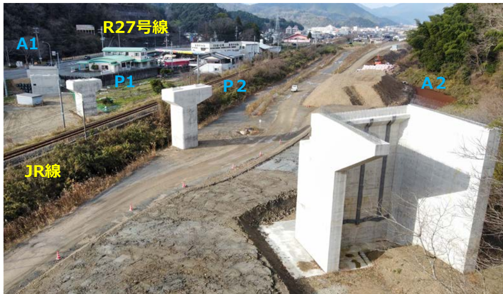
西舞鶴道路京田ランプ橋下部工他工事
