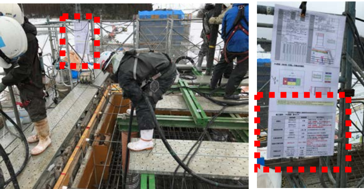
打設状況（実施事項周知）
