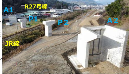
西舞鶴道路京田ランプ橋下部工工事
