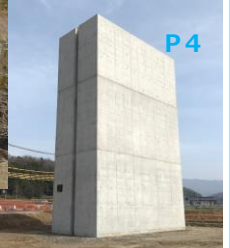
大宮峰山道路第一高架橋P4橋脚他工事
