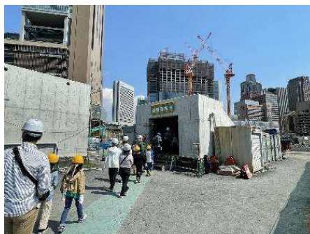
11. 地下への入退場は、完成後は一般に使用されることのない非常階段で昇降してもらいました。
