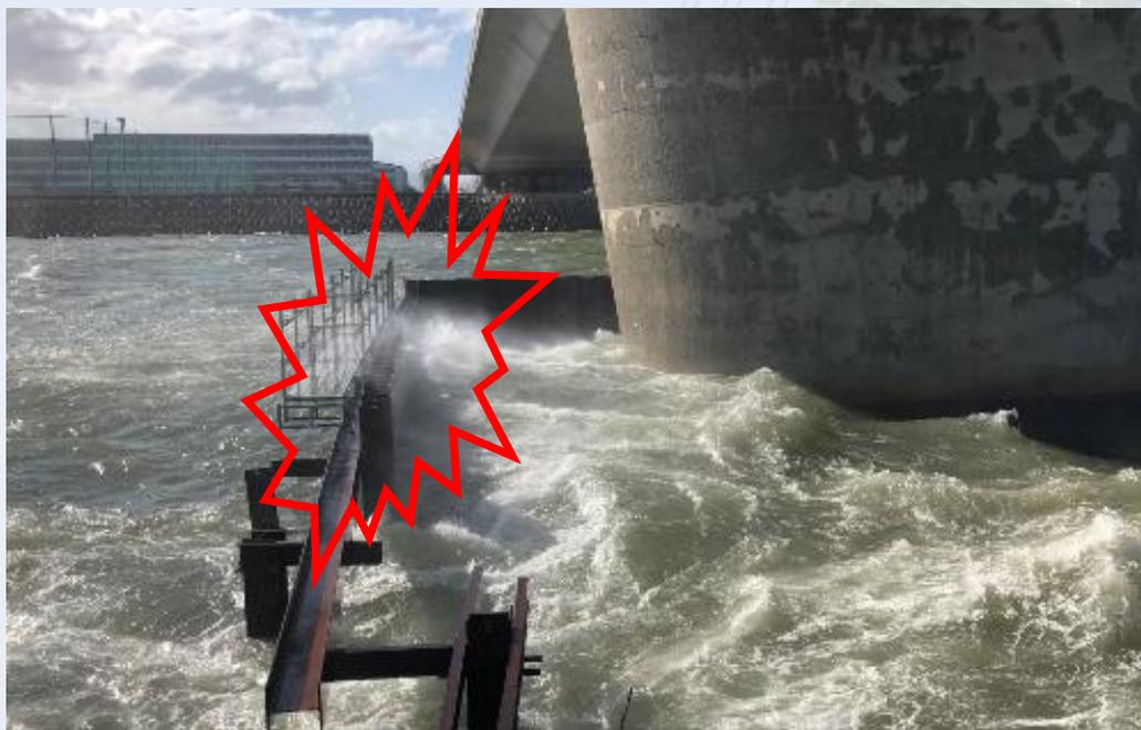
荒天により想定外の高波となり、仮締切内部が水没し、引き波による外側への引張力により損傷
