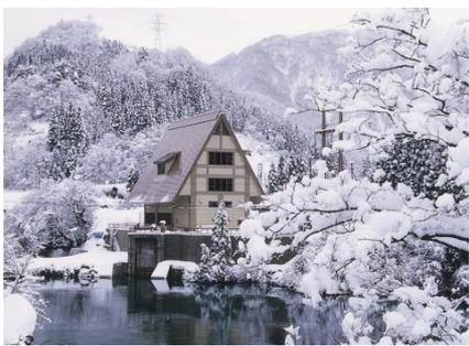
成出発電所・新成出発電所にて使用されていた加須良川の水を、隣接する境川へ引水し、約4倍の落差の境川発電所で使用することで、発生電力量増加
