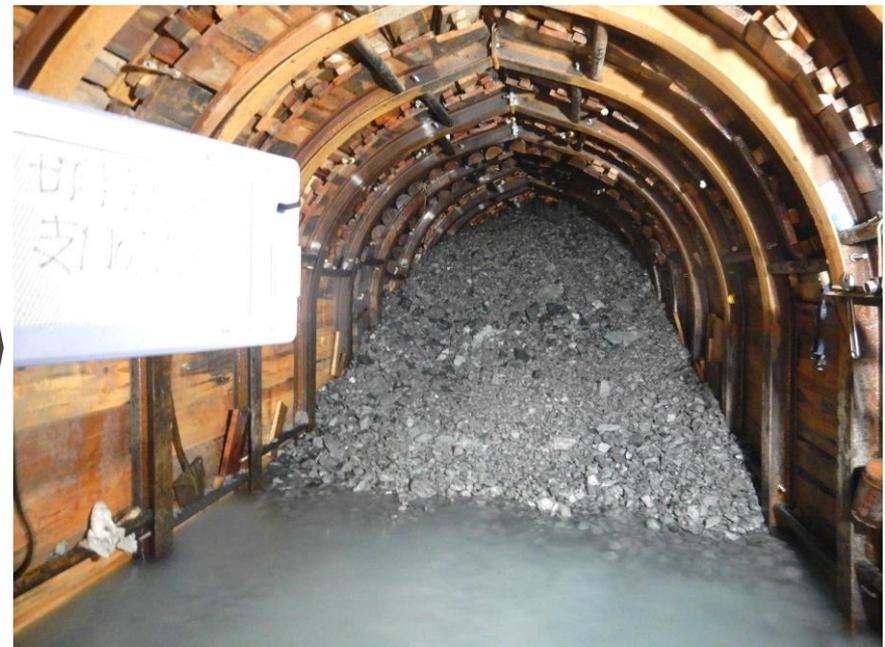
掘削中に突如**多量の湧水**が発生し、その後、湧水に伴う**大規模な土砂崩落**が発生
