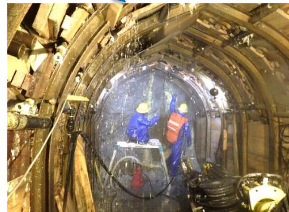
トンネル坑内各所で断面変形、土砂崩落、湧水が発生し、掘削作業は困難を極めた
