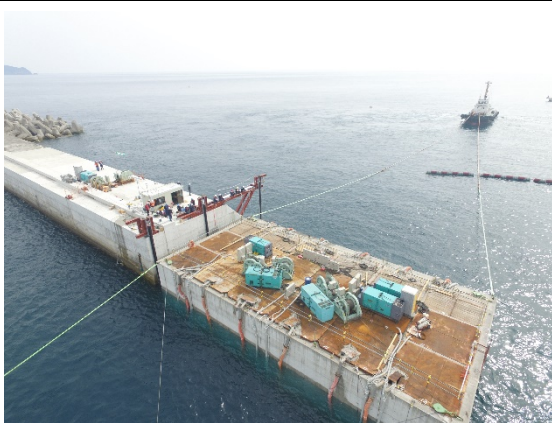
防波堤（建設中）
