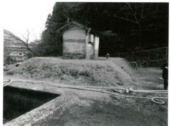
■荒船浄水場(緩速ろ過池と浄水池)
