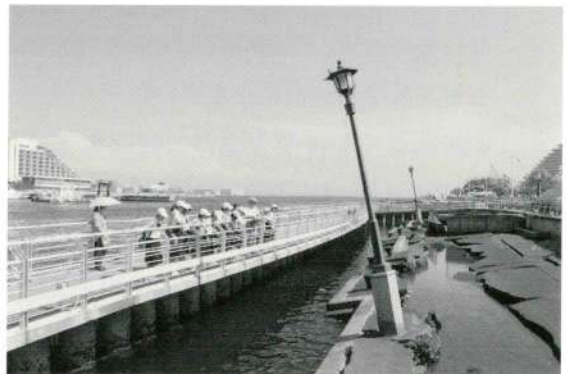
■ 修学旅行生と震災遺構巡り（神戸港震災メモリアルパーク）
