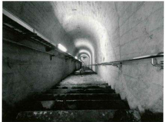
■堤体内部の監査廊(急な階段)
