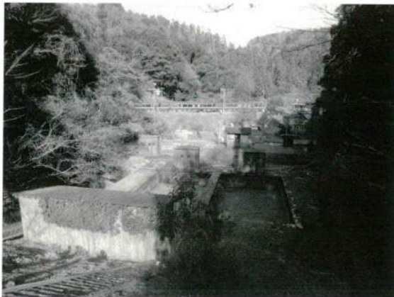
■荒船浄水場(水源池堰堤からろ過池を見る)
