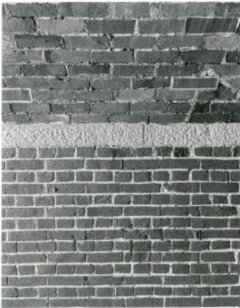
■二号暗渠(煉瓦の特徴を意識した補修)
