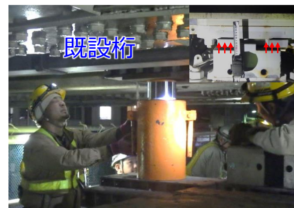
【既設桁地切り試験】
