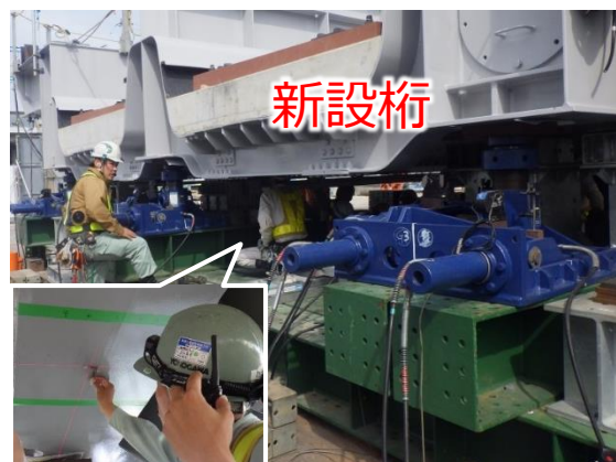
【ベント上ジャッキ調整試験】
