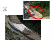
既設土留擁壁に荷重を 作用させないため、軽 量盛土を活用して仮設 道路を設置
