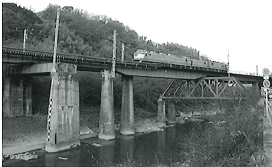
■第4大和川橋梁
