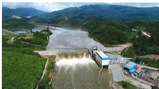
■逆調整ダム（ラビリンス式洪水吐）および発電所
