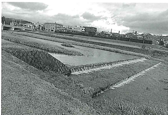
■曲線と石積・石張で構成された床止堰堤
