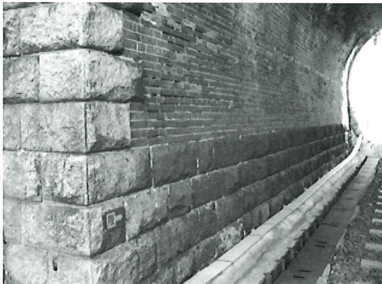
■トンネル内部
