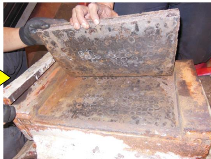
(d) 下沓・ベアリングプレート解体
