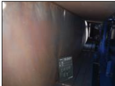
写真-3 足場内密閉状況
