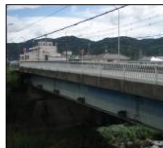
写真 - 1 施工前全景
