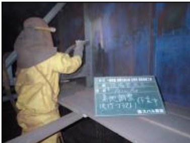
写真-2 プラスト作業状況
