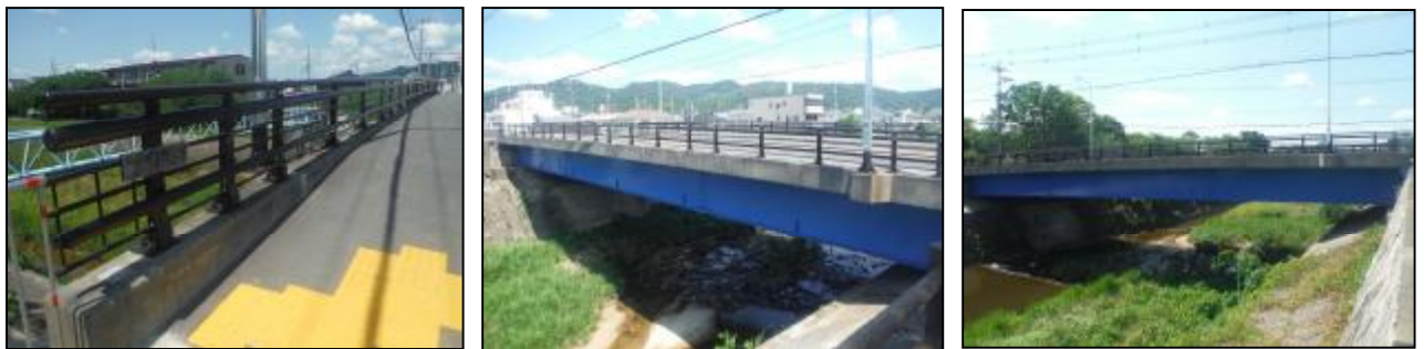
写真-6 施工完了後写真
