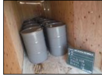
写真-5 塗膜かす保管状況
