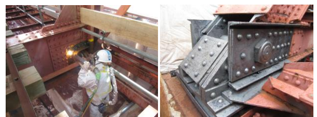
(a) 作業状況 (b) ケレン完了
