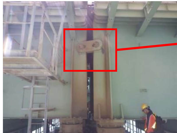
写真④ 耐震連結工付近の腹板の変形
