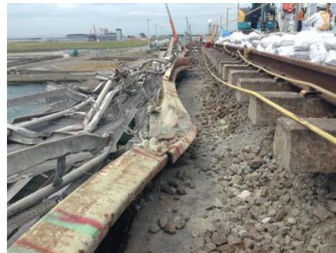
写真② バラスト止めの損傷
