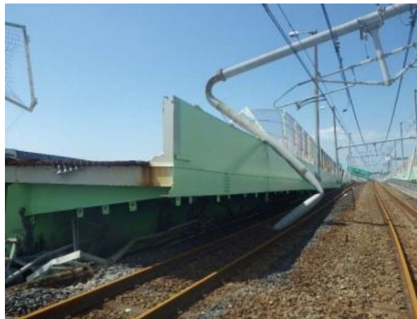
電柱の応急復旧検討 (門型から片持ち式へ)
