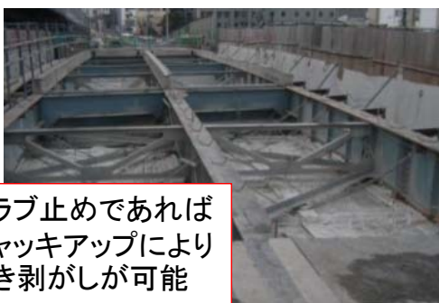
ジャッキによる引き剥がし作業
