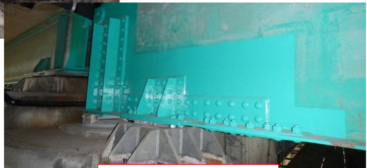
部材取替＋当て板補修を実施
