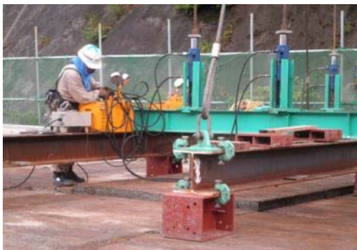
ジャッキによる引き剥がし作業
