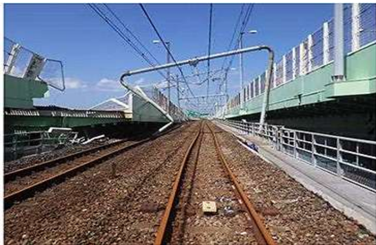
電架柱の破損
