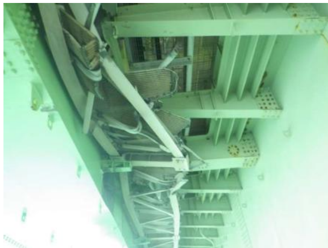
写真⑤ P 2 付近橋側歩道 ブラケット損傷状況
