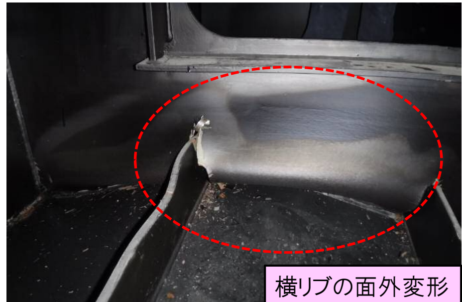
垂直補剛材の面外変形
