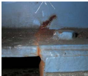
H26 発見 同年補修完了 (部材・支承取替)
