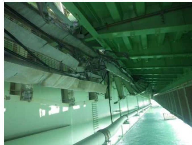
写真⑥ P 1 付近橋側歩道 ブラケット損傷状況
