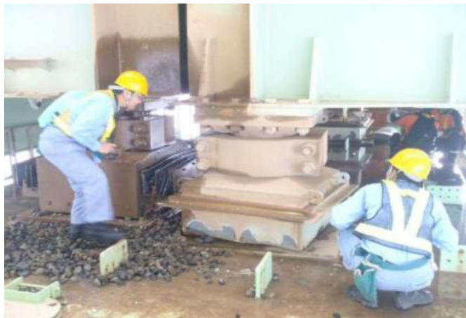
破損した支承の調査
