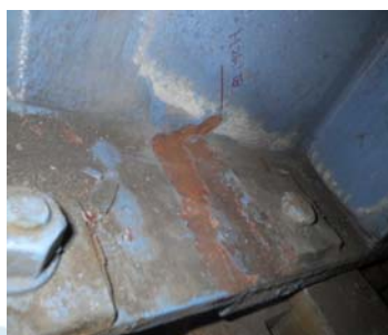
H26 発見 H27 補修完了 (部材・支承取替)
