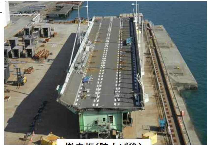
撤去桁(陸上げ後)
