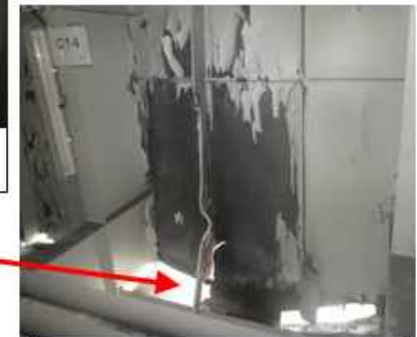
ウェブ破断、変形
