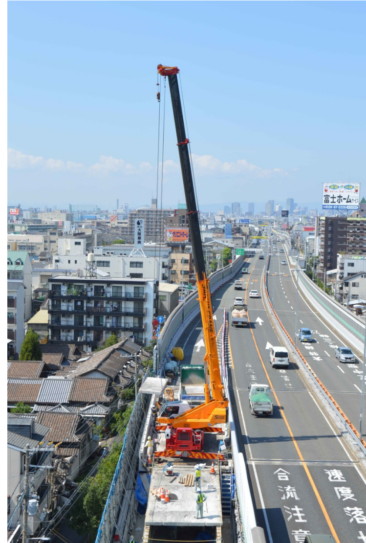
床版撤去状況
