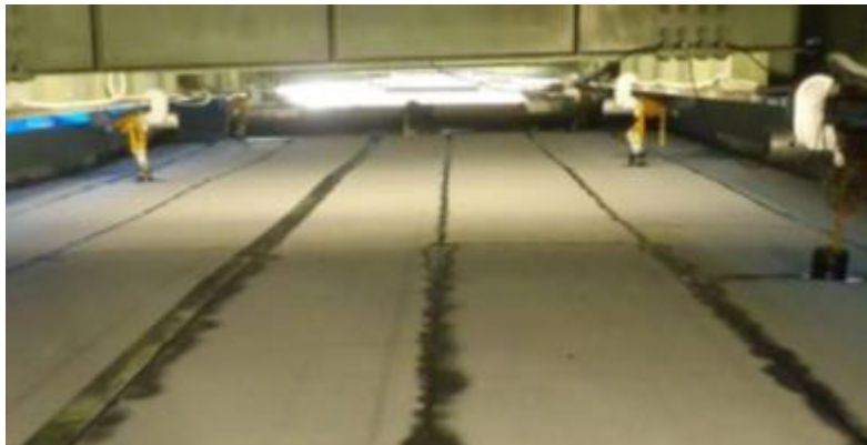
アスファルト防水シートの設置 (床面)
