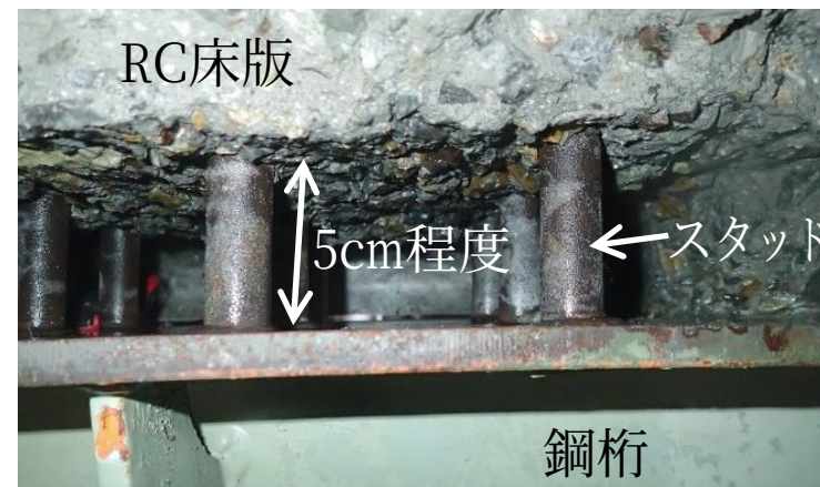
RC床版と鋼桁接合部コンクリートの除去状況
