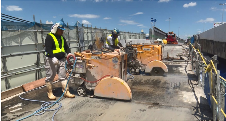
床版切断状況
