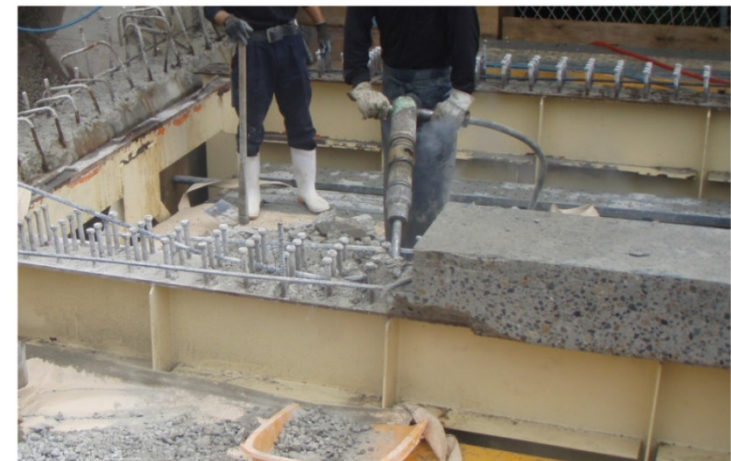
主桁上床版はつり状況
