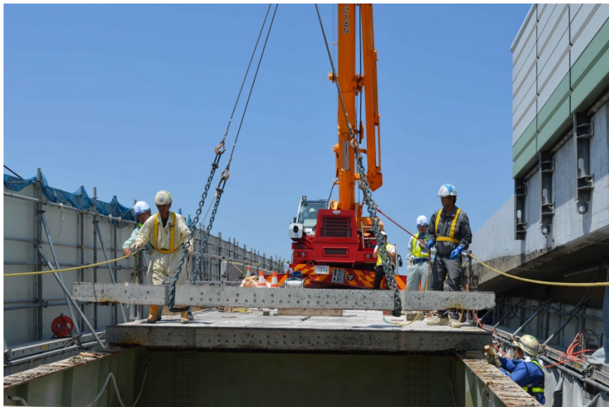
床版撤去状況
