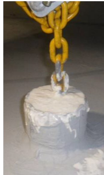
吊チェーン周りへの シリコン充填
