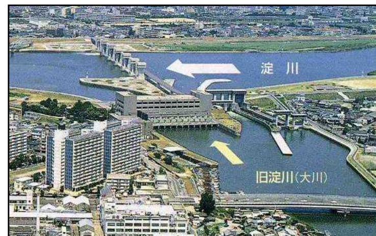
毛馬排水機場
