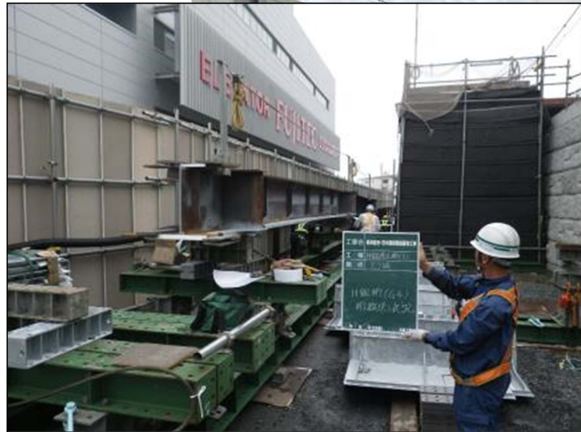
H鋼埋め込み桁 主桁の地組状況
