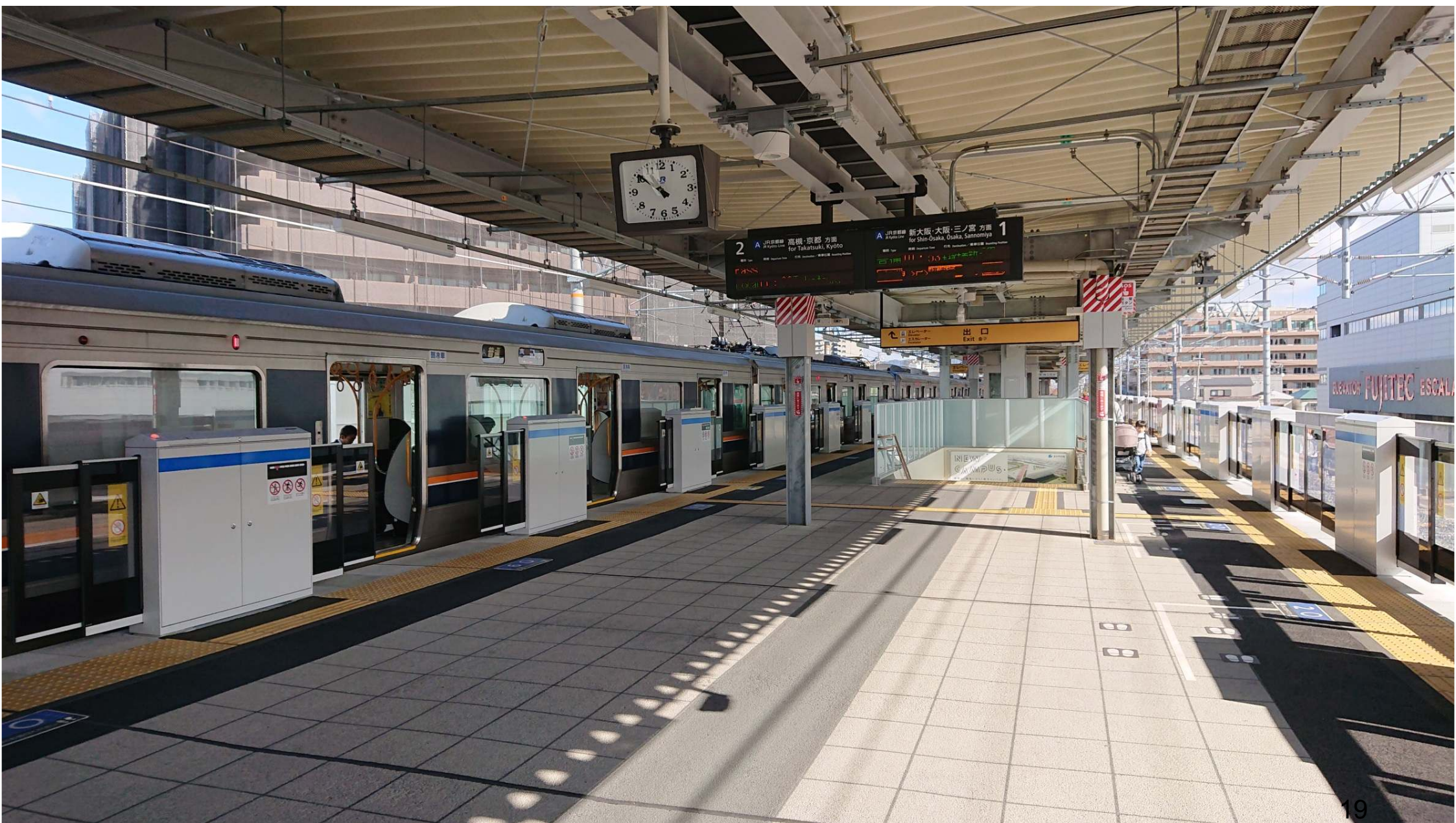
二重引き戸式ホームドアと石畳風の透水性As舗装の採用
