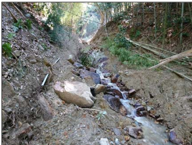
P3 調査時は、7/15 被災後も谷流水多し。
