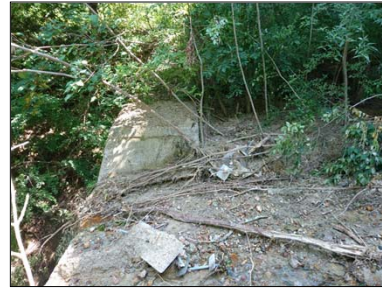
P2 砂防堰堤 2基有り。ほぼ、土砂で満タン。 被災前はどうかだったか？
