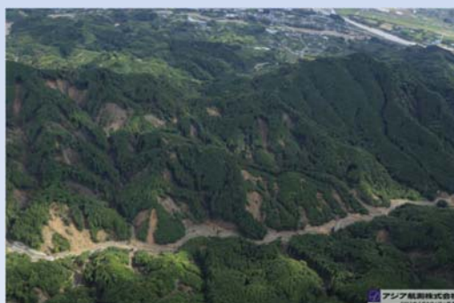
2017年九州北部災害 奈良ヶ谷川崩壊
