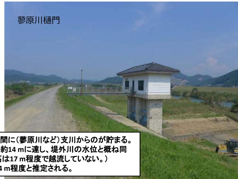
宮福線盛土と由良川堤防に囲まれた区間に(蓼原川など)支川からの水が貯まる。今回の豪雨では、堤内側の水位が標高約14 mに達し、堤外川の水位と概ね同程度となっていた(由良川本線の堤防高は17 m程度で越流していない。) 大江町蓼原地区の最大浸水位も概ね14 m程度と推定される。
