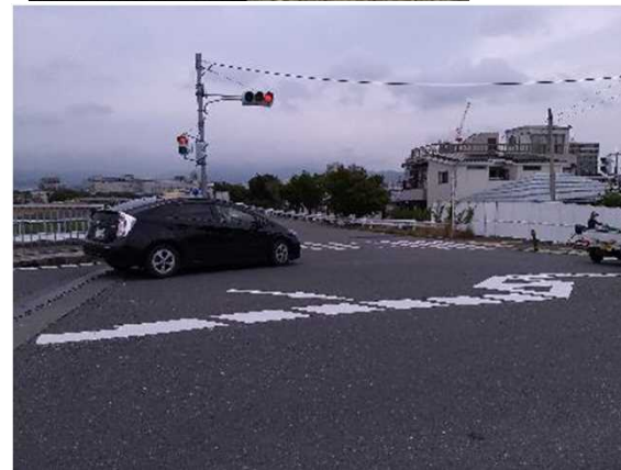
じょうさい橋以北は堤防被害なし (天端幅:約5m), 川表側法面下部保護工あり
