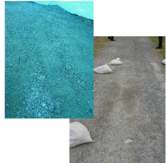
亀裂への注入跡 ブルーシートで養生
