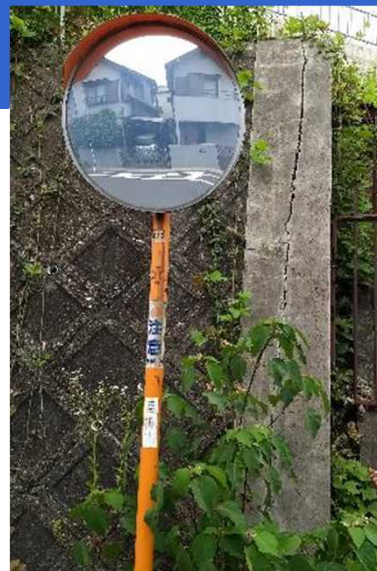
上水道施設擁壁(亀裂数か所)
