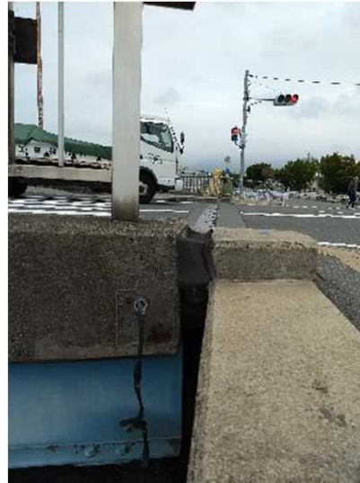
じょうさい橋東取り付け 部スライダーずれ
