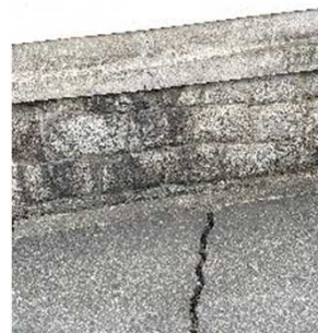
上水道施設擁壁(亀裂数か所)
