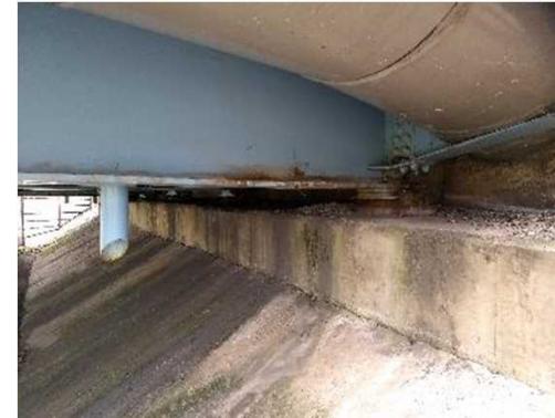
じょうさい橋東取り付け 部スライダーずれ
