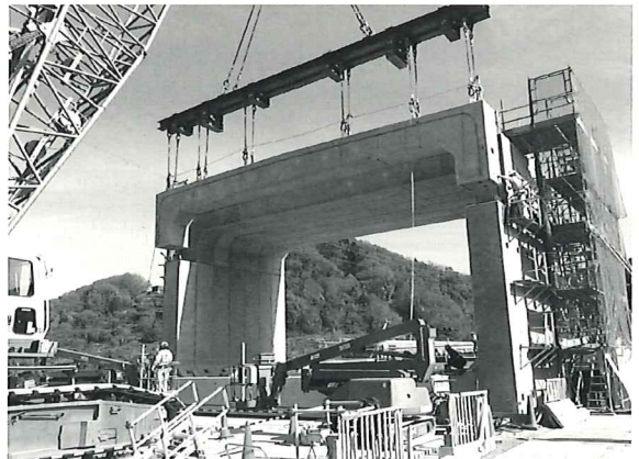
■専用吊具（バランスビーム）による上部材の据付状況
