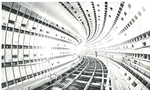
■中央北増補幹線 一次覆工の状況（プロカメラマン撮影）
