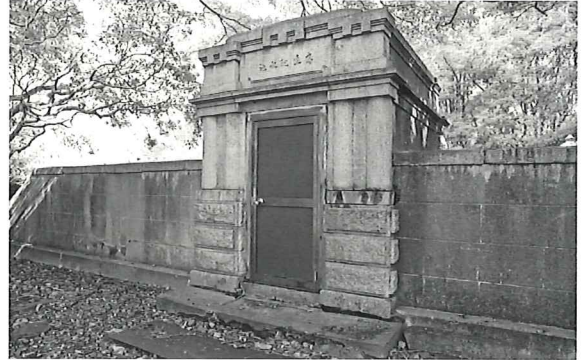
■高地区配水池上屋入口
