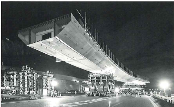
■名神高速道路上の桁運搬時 (写真提供：宮地・東骨特定建設工事共同企業体)
