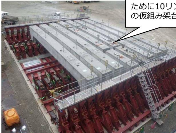
1日2リングの施工サイクルを実現するために10リング分の仮組み架台を設置
