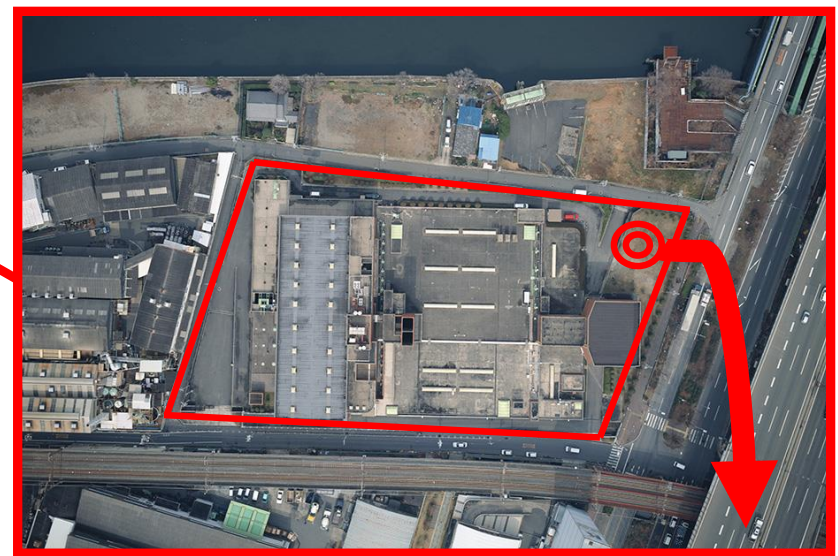
寺島ポンプ場の状況
