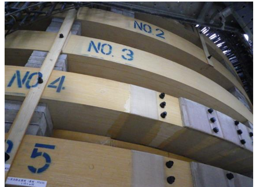
FFU加工部材設置状況(SEW工法)
