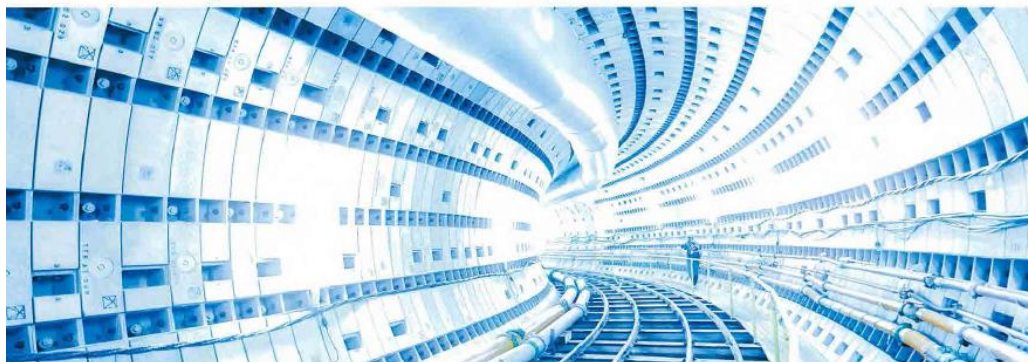
～中央北増補幹線外(第1工区)シールド～
