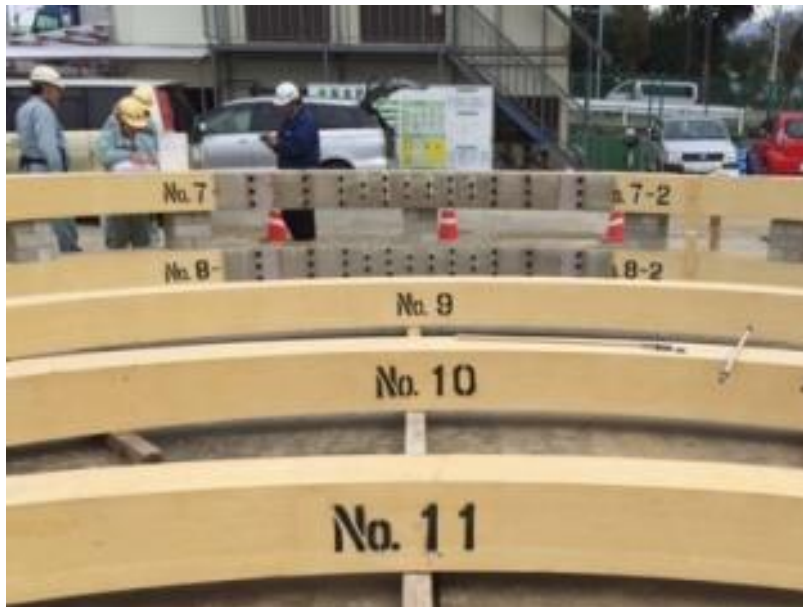
FFU部材(合成木材)(SEW工法)
