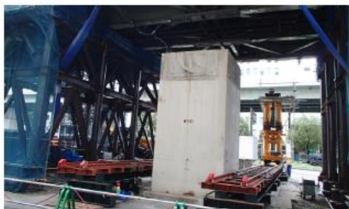
橋脚梁部撤去完了
