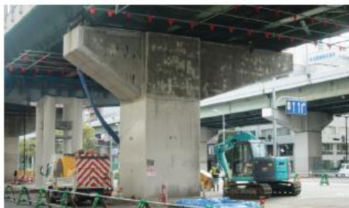
再構築工 着手前
