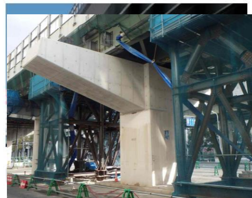
再構築梁完了断面
