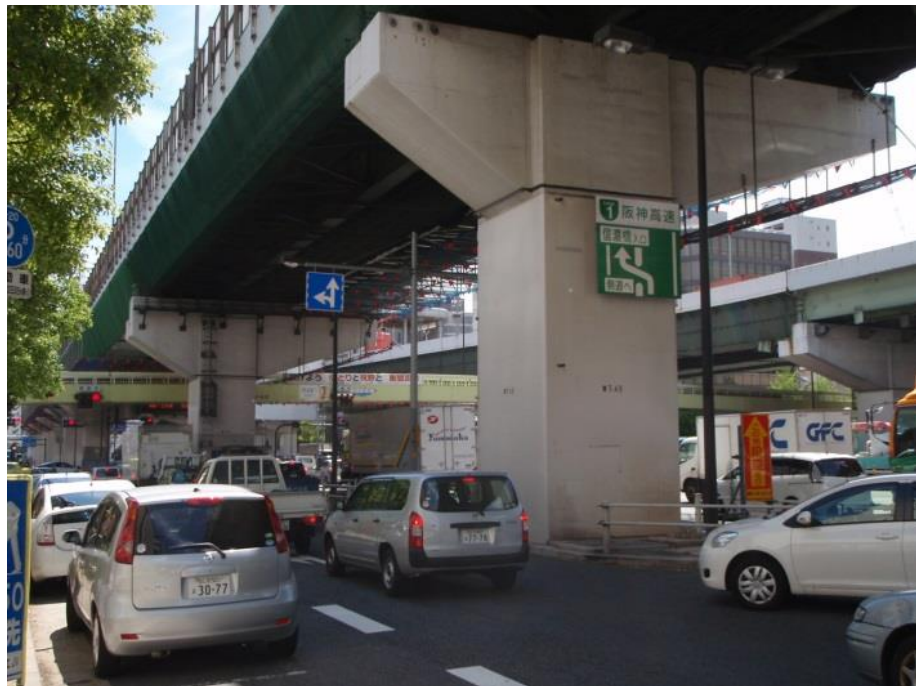
現地状況(施工前)
