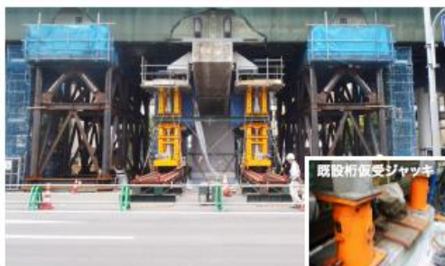
仮受橋脚及び荷受けジャッキ設置完了
