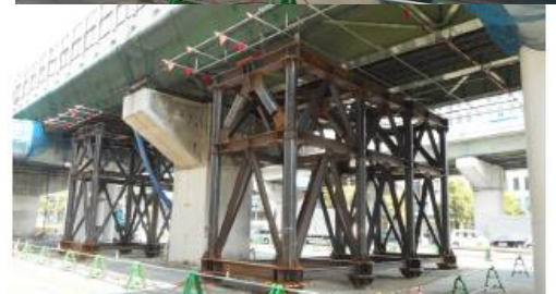
梁再構築工(コンクリート打設支保工)
