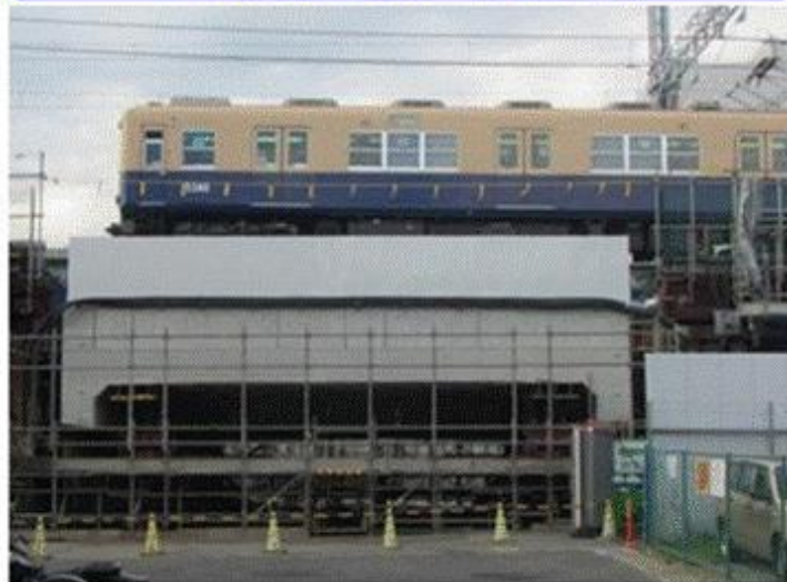
ジャッキアップ前
