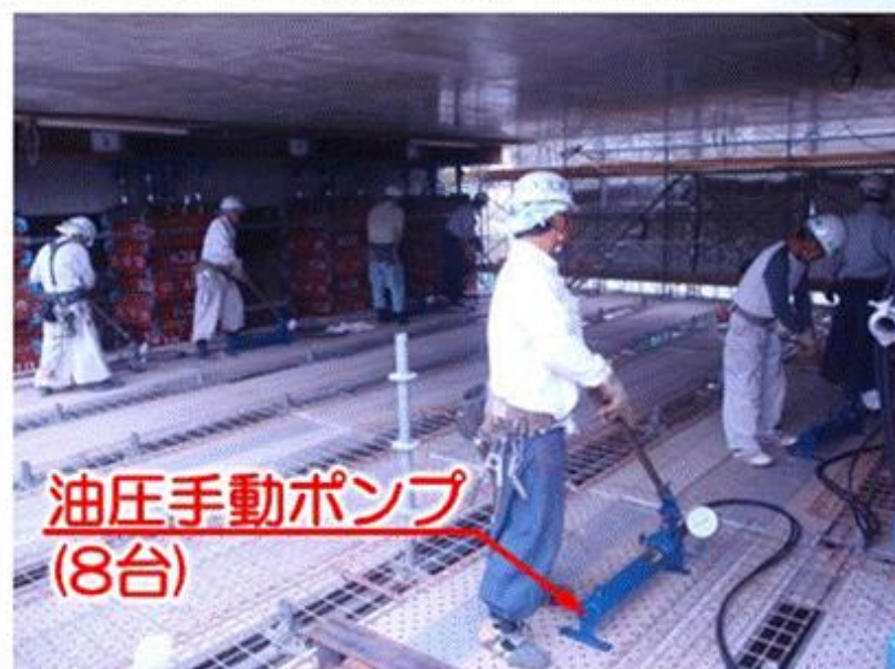
位置調整作業状況
