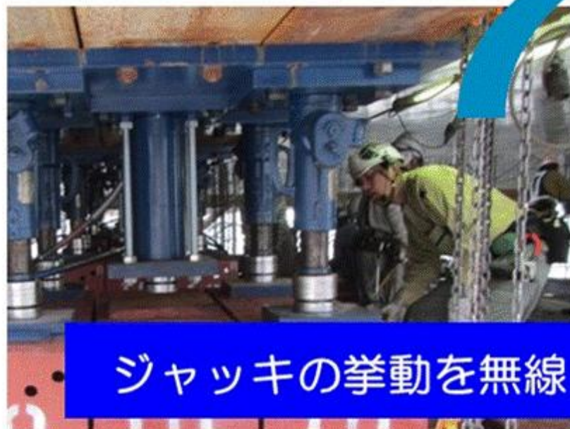
現場ジャッキ部
