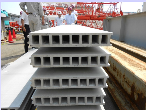
天井板断面構造
