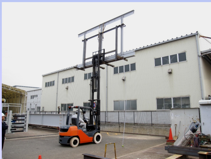
中央金具撤去の試験施工
