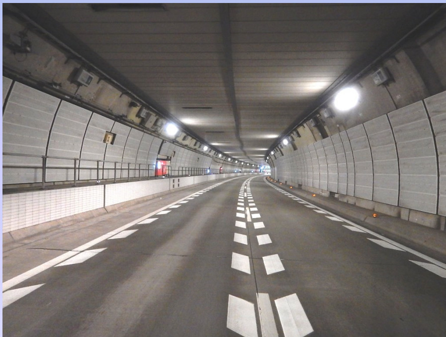
神戸長田トンネル (天井板撤去前)
