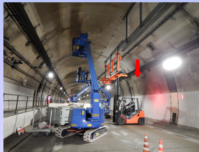
撤去作業状況
