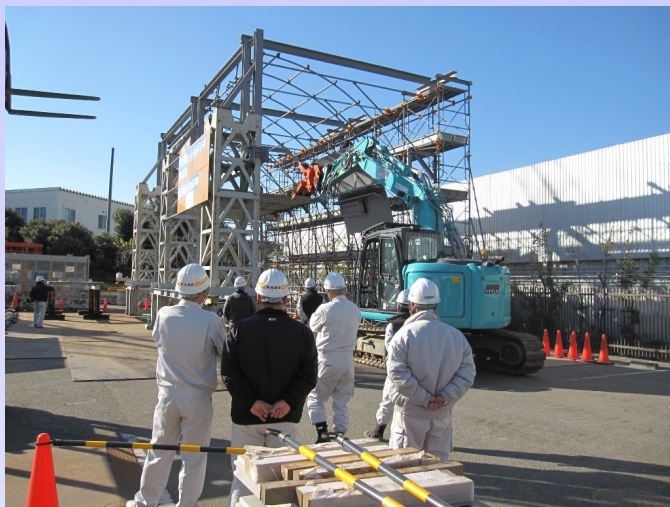
ハンドリングマシンに よる天井板取外し
