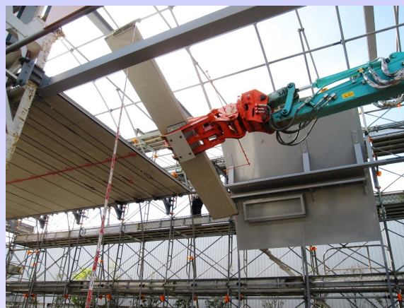
試験施工の様子
