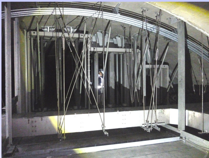
換気塔接続部
