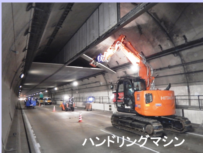
① 天井板撤去 (フォークリフトは前方待機)
