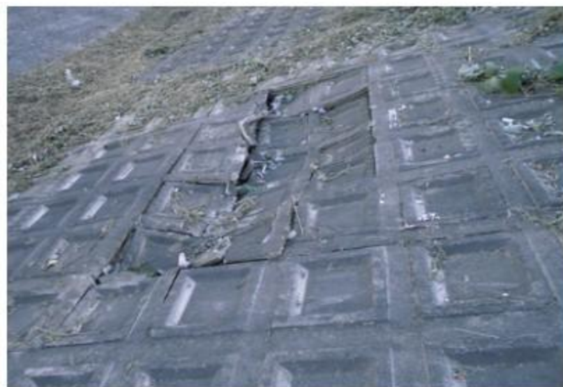
護岸の損傷
