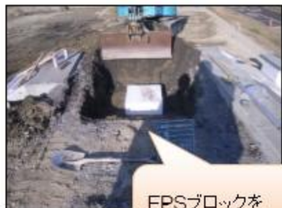
EPSブロックを埋設し、空洞を再現
