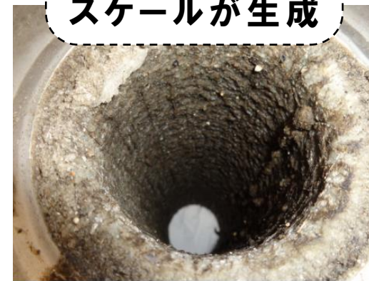
バイパス管使用 (延べ47日)
