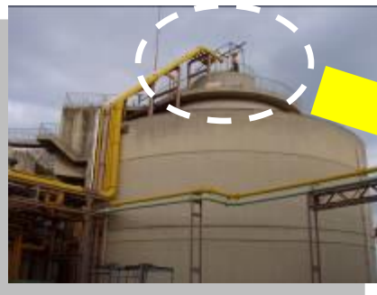
上下円錐型 消化タンク (垂水処理場)
