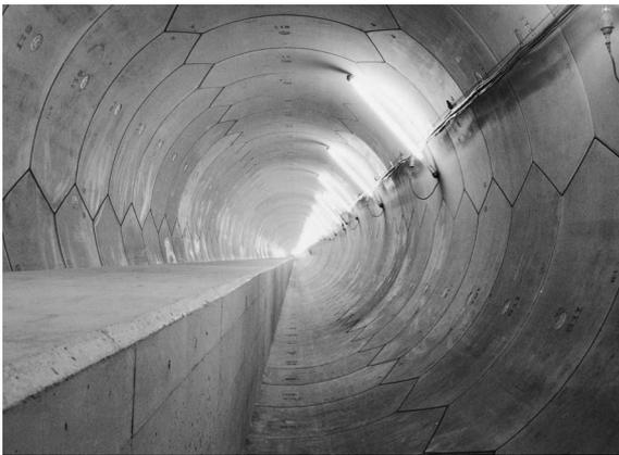
■ハニカムセグメントを用いて二次覆工を省略した雨水管渠
